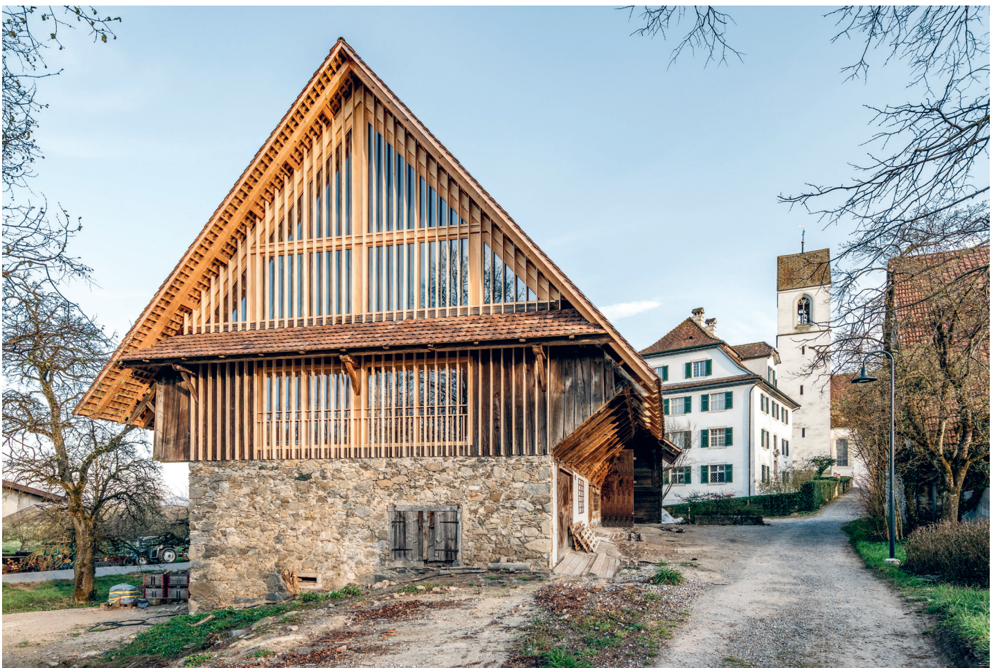
Flächen statt Löcher: Vor der fast vollverglasten Giebelfassade sorgen Holzlamellen für Ruhe und Einheit.
