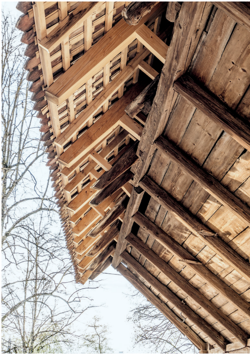
So einfach, wie die Handwerker einst die Rafen über den Kammeranbau spreizten, stützen neue Pfosten das gedämmte Dach von den Pfetten ab.
