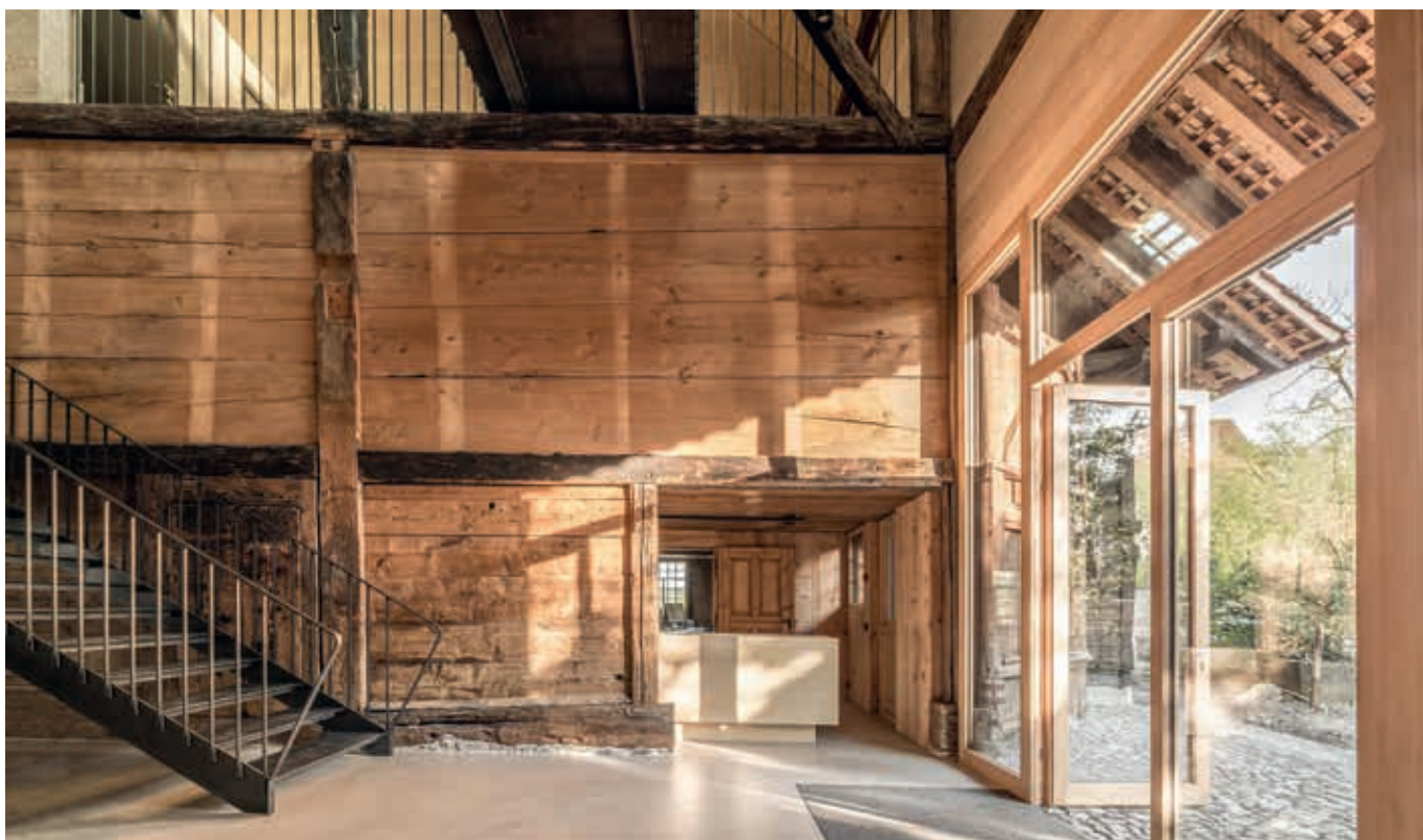
7 Im Eingangsfoyer sind an den Wandbohlen seitlich der Metalltreppe noch Helligkeitsunterschiede auszumachen, die von Tragbalken stammen, auf denen diese Bretter einst lagen.
