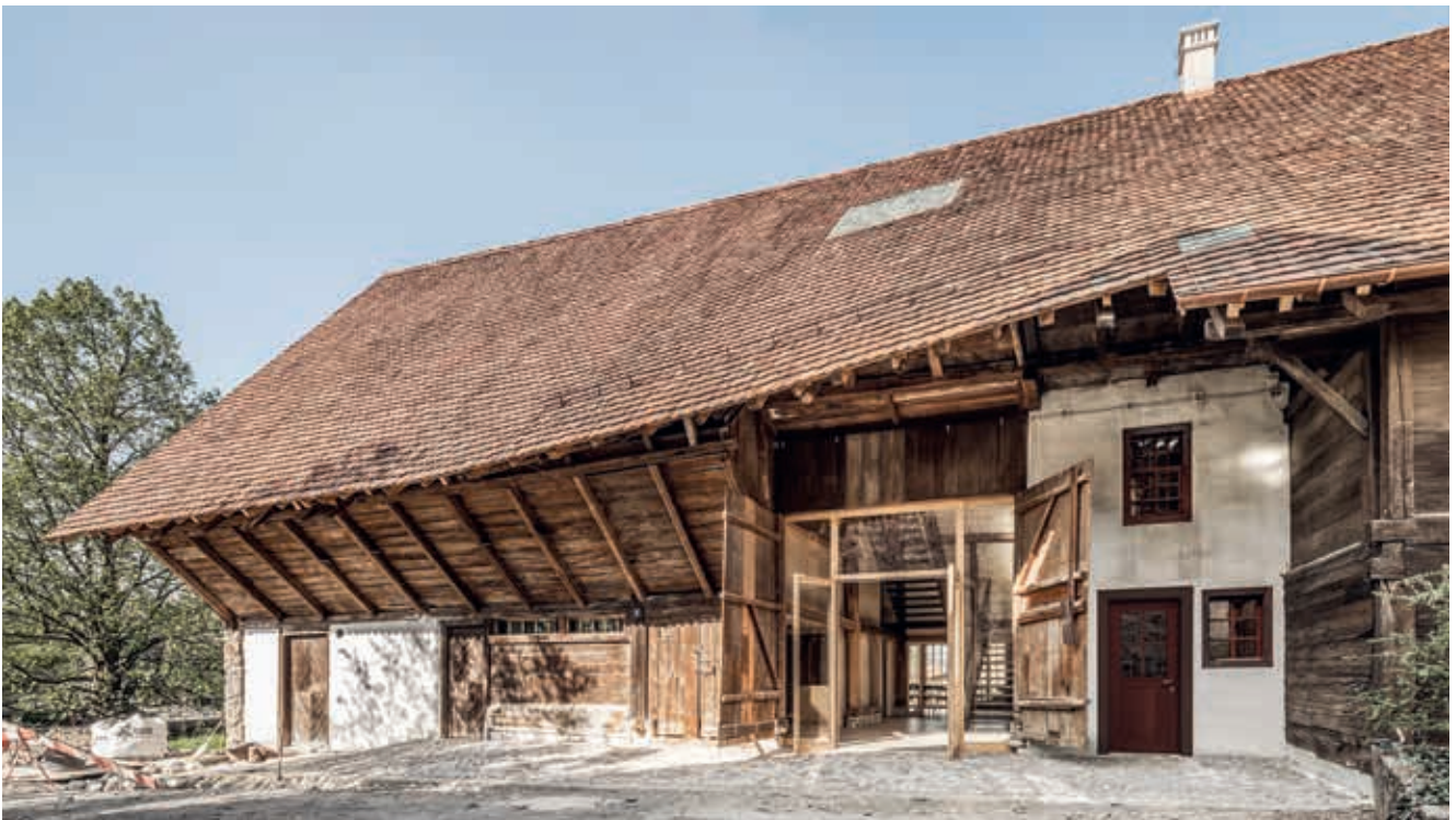
4 An den Wohntrakt angebaut sind das ehemalige Tenn und ein Stall. Die Welle im Dach zeugt von einer früheren Aufständigung.
